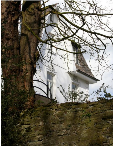
Abb.2: die Original Mauer auf der Rückseite
