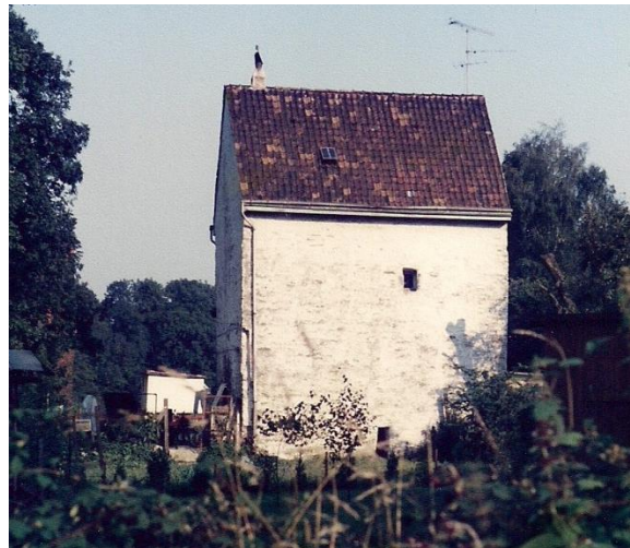
Abbildung 2: Gödinghoven vor dem Umbau, vor 1990, eigenes Foto
