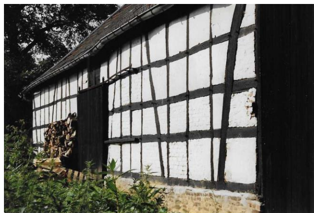
Abbildung 1: Fachwerkscheune Westseite 1995, eigenes Foto
