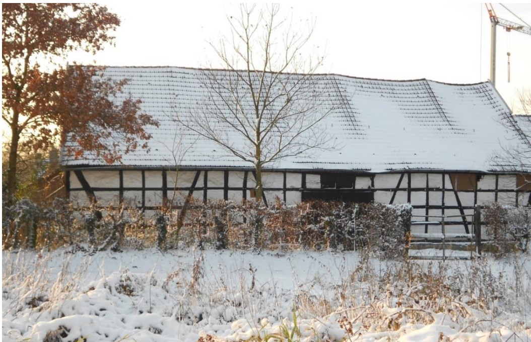
Abbildung 4: Fachwerkscheune Hochscheid im Winter 2012, vor der Renovierung, eigenes Foto
